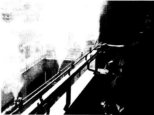
写真-3 自宅(名古屋市千種区)での適用例 集合住宅の規模、3LDK(57㎡×2戸) なごミストの仕様： 1住戸当りノズル4個 噴霧量：200ml/分
